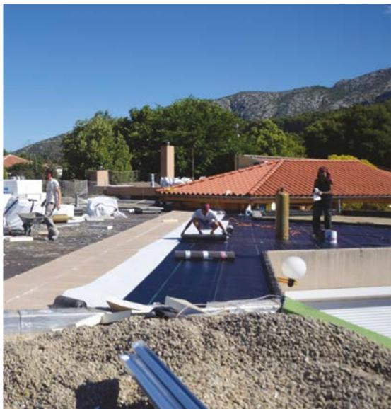
Grâce aux travaux de l'été, l'étanchéité de la toiture de l'école maternelle Vessiot est désormais assurée, pour le confort des élèves et des professeurs.
